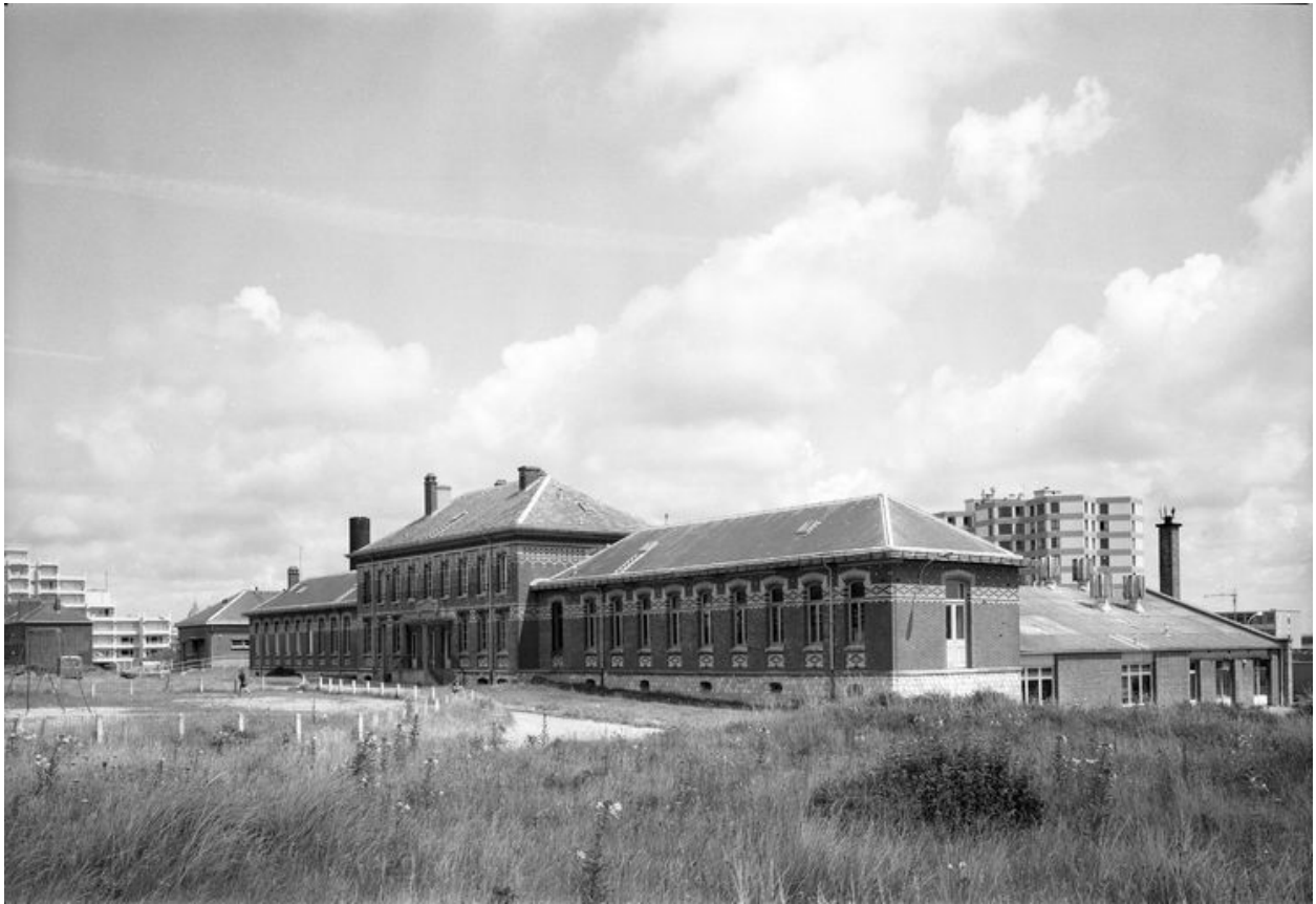
Bâtiment d'isolement des enfants contagieux ajouté en 1909 sur l'arrière de l'édifice primitif, vue générale prise de trois-quarts droit.
