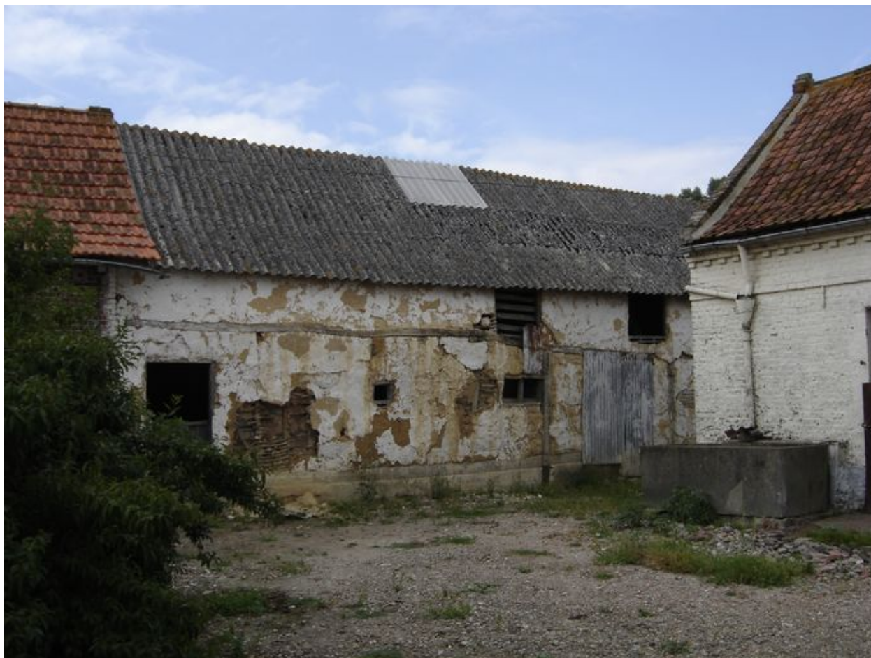
Vue de la grange.
