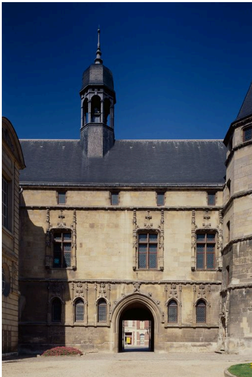
Elévation postérieure, détail.
