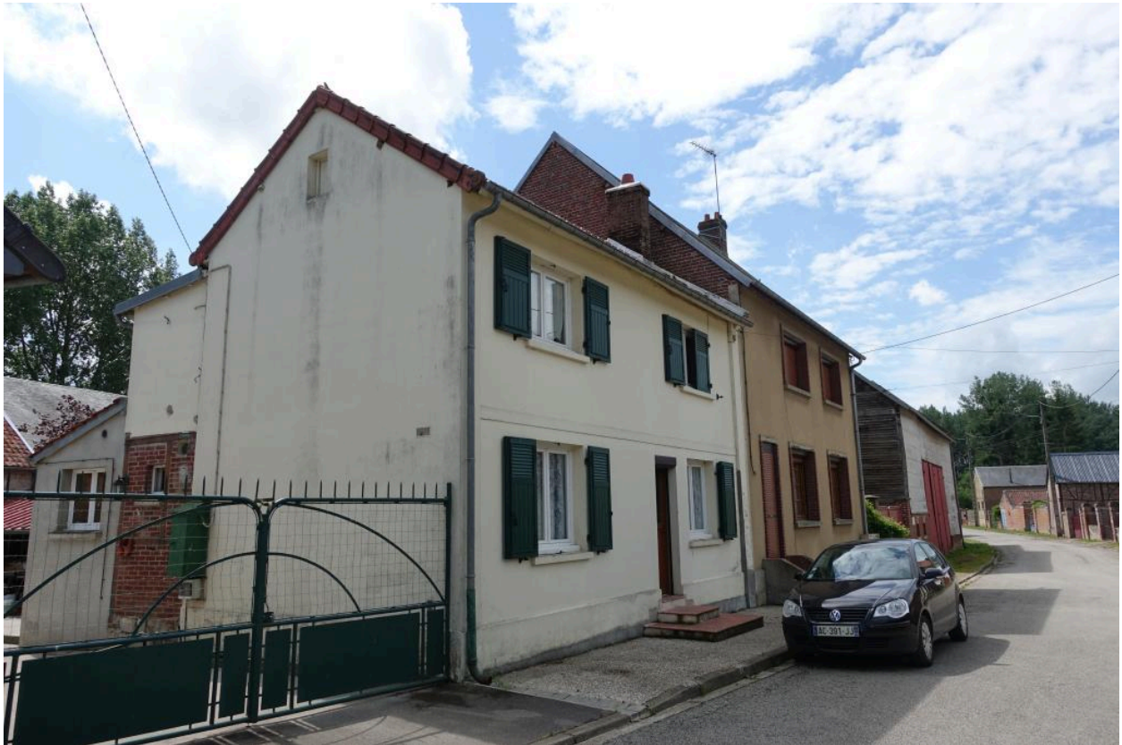
Logis sur rue (reconstruits après l'incendie de 1940?), n°10 et 12, vue depuis le nord.
