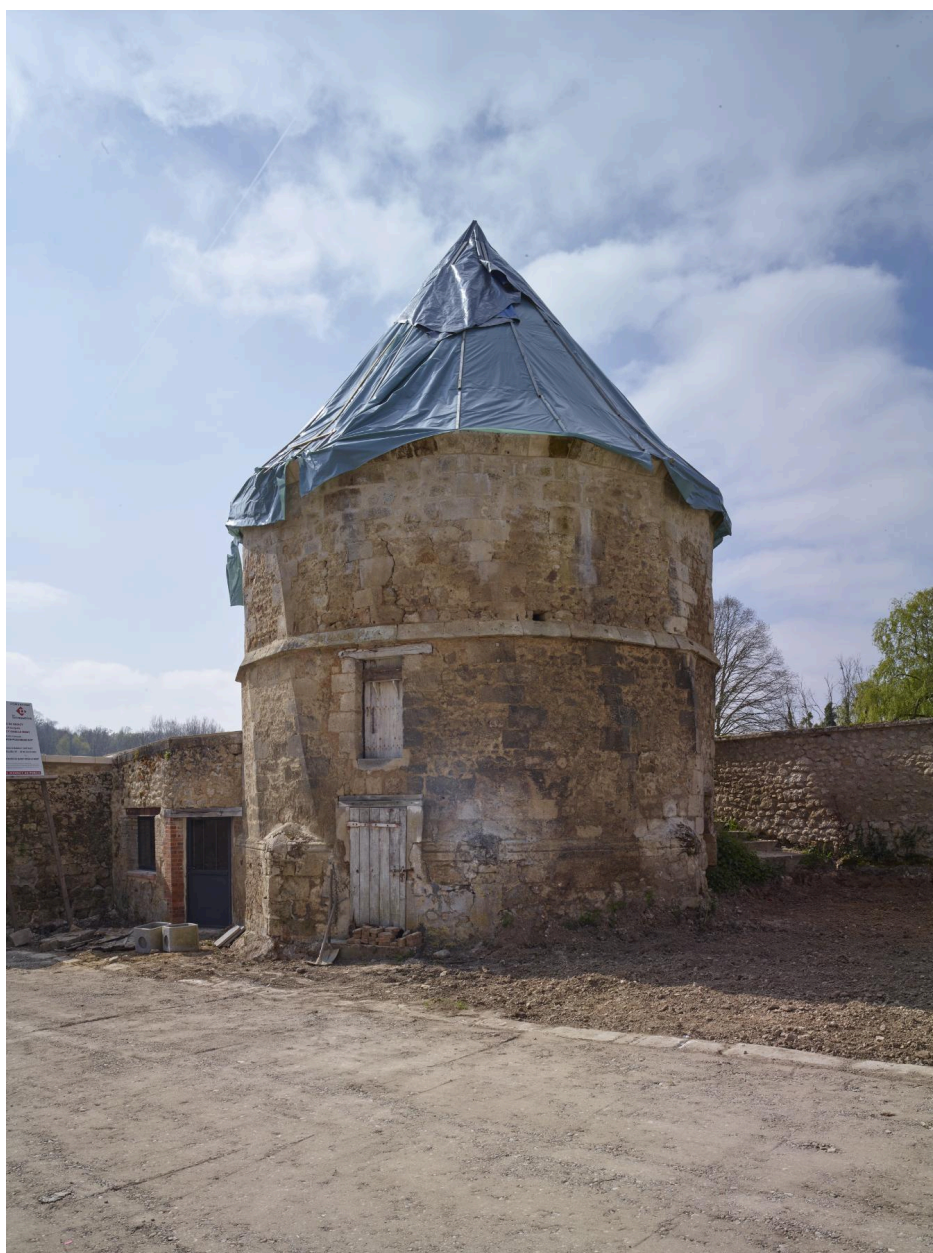
Vue générale du colombier prise depuis le nord-est.
