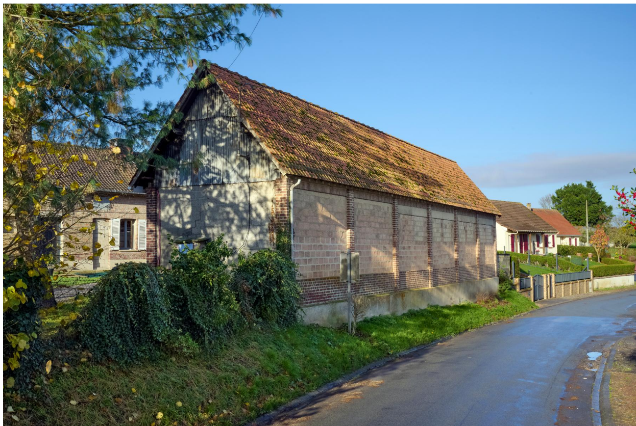
Bâtiment agricole, 17 rue d'Abbeville, depuis le sud-est.
