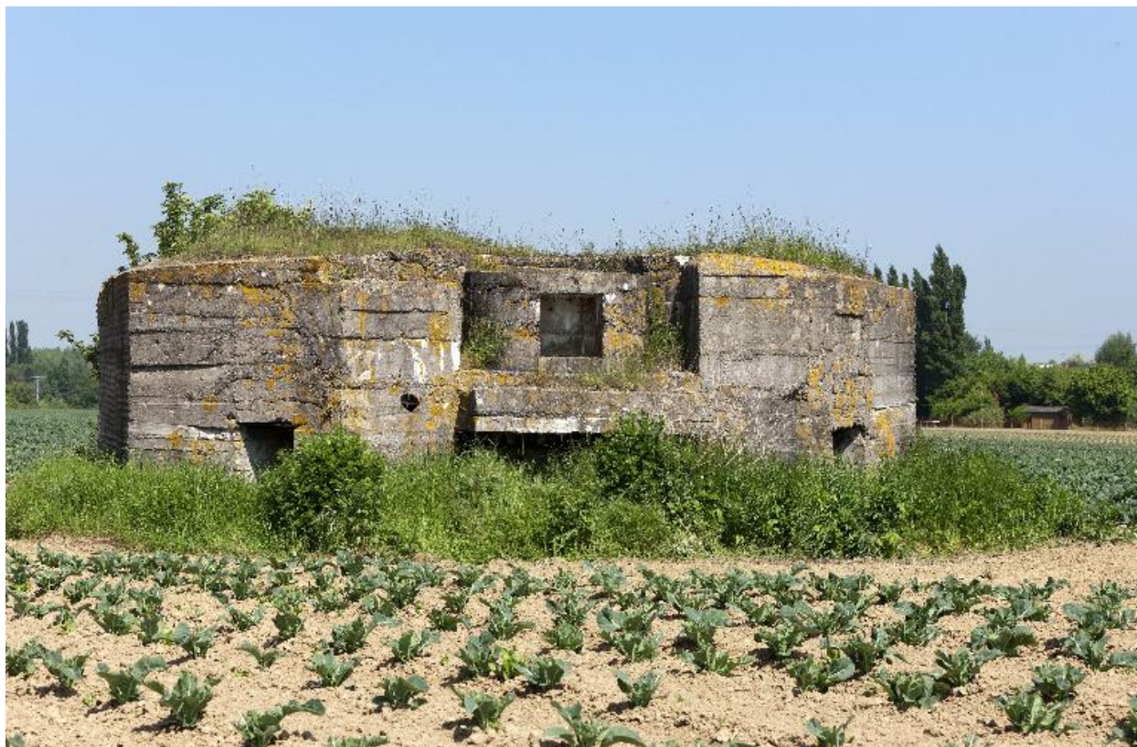
Vue antérieure, vers le nord-ouest.
