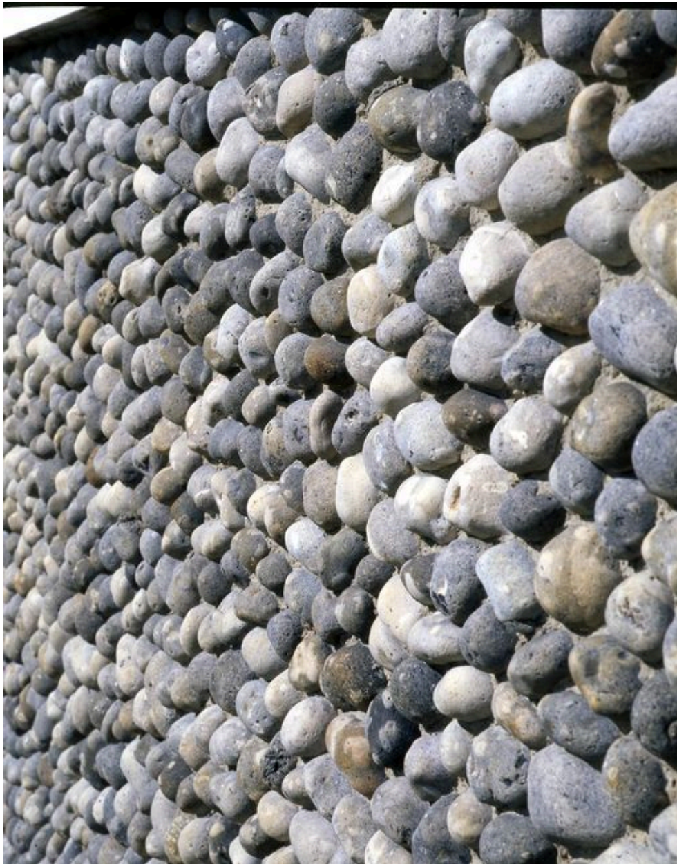
Détail du parement en galets de silex du soubassement, casino actuel.
