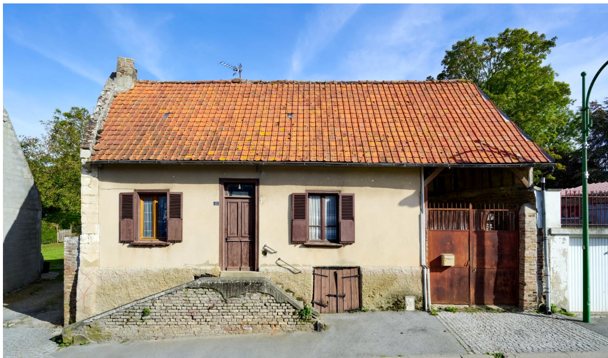
Maison, depuis le sud.
