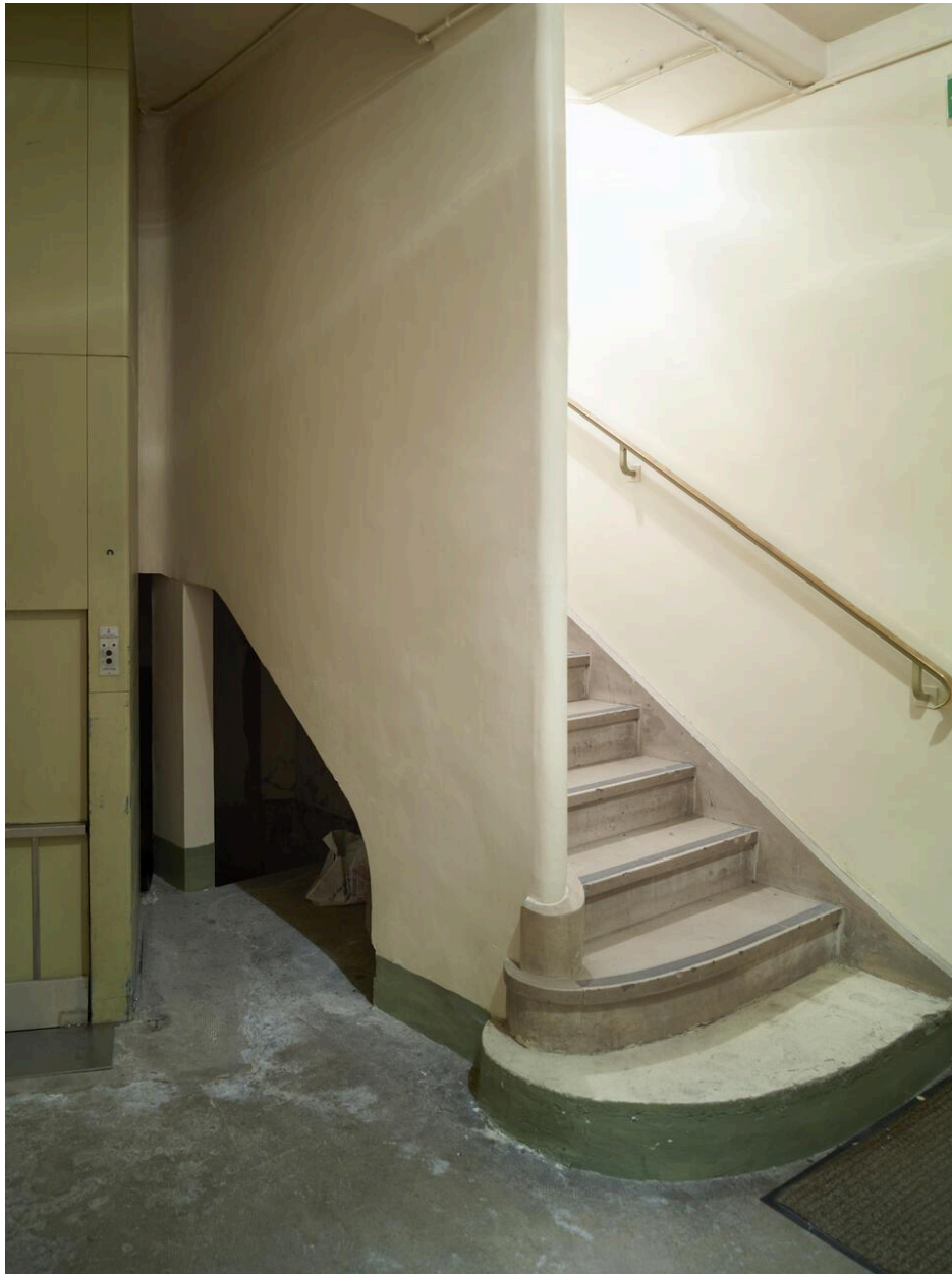
Sous-sol, escalier menant aux caisses du rez-de-chaussée.
