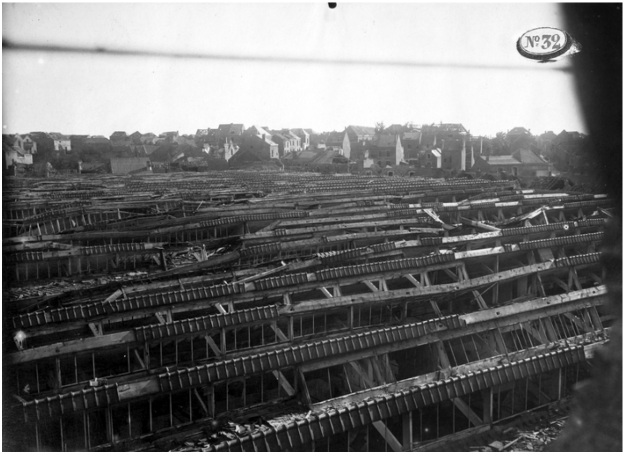
Vue générale des toits des ateliers en direction du sud-ouest, vers 1919 (AD Aisne).
