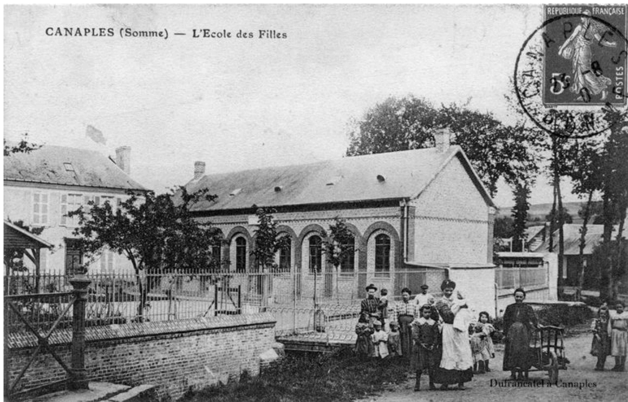
Vue générale, avant 1910 (coll. part.).
