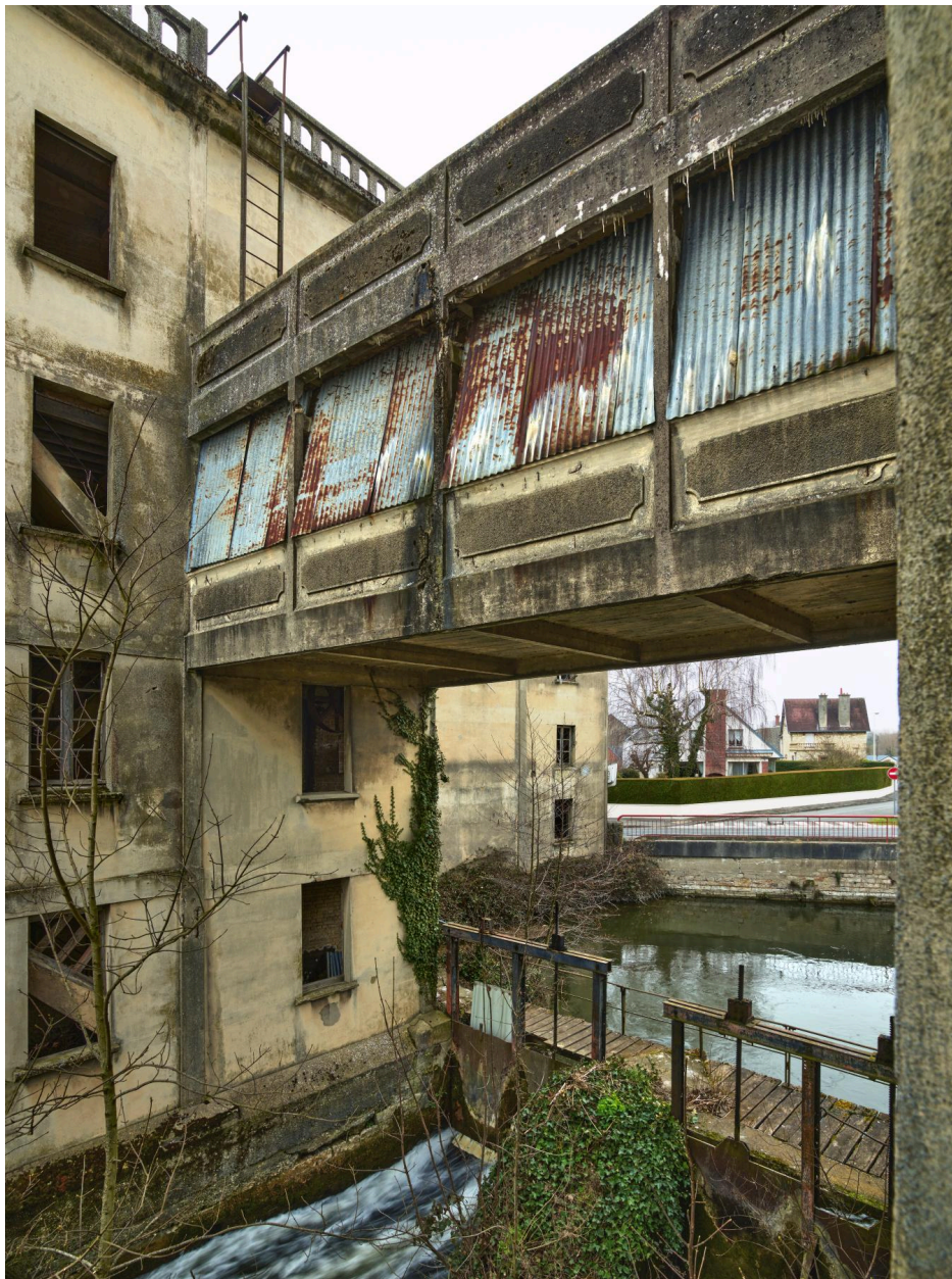
Galerie surplombant la coulerie centrale de la minoterie.
