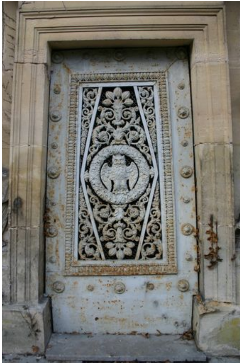
Détail de la porte trapézoïdale en fonte ouvragée et moulée.
