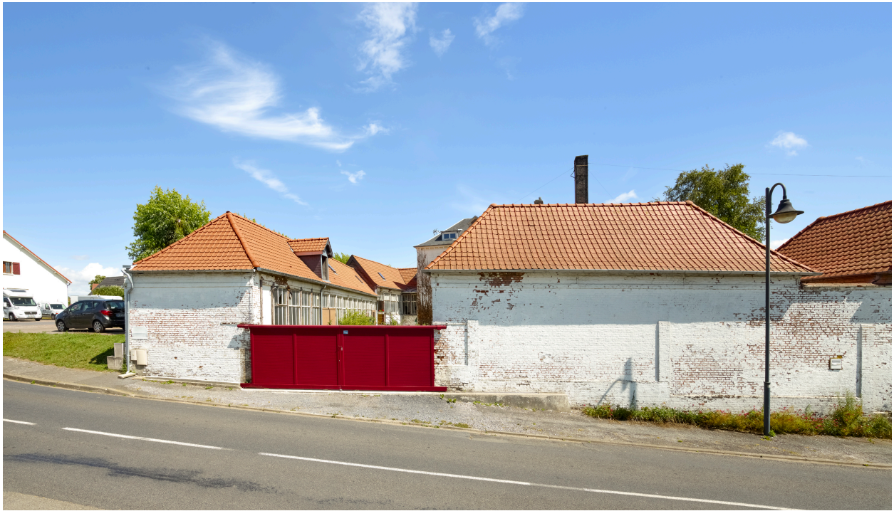
Vue des premiers ateliers, depuis l'ouest.
