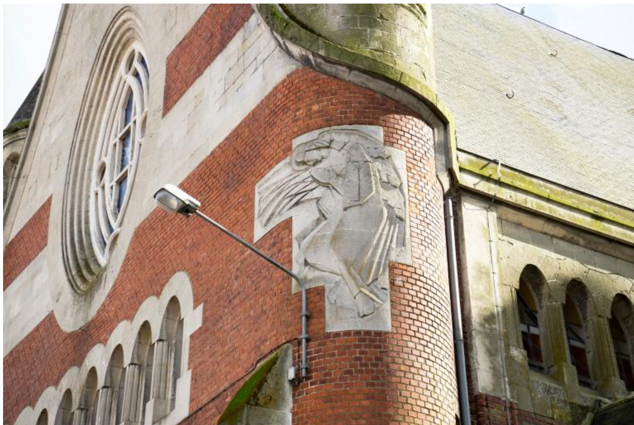
Un des deux anges sculptés encadrant l'élévation antérieure de la nef.
