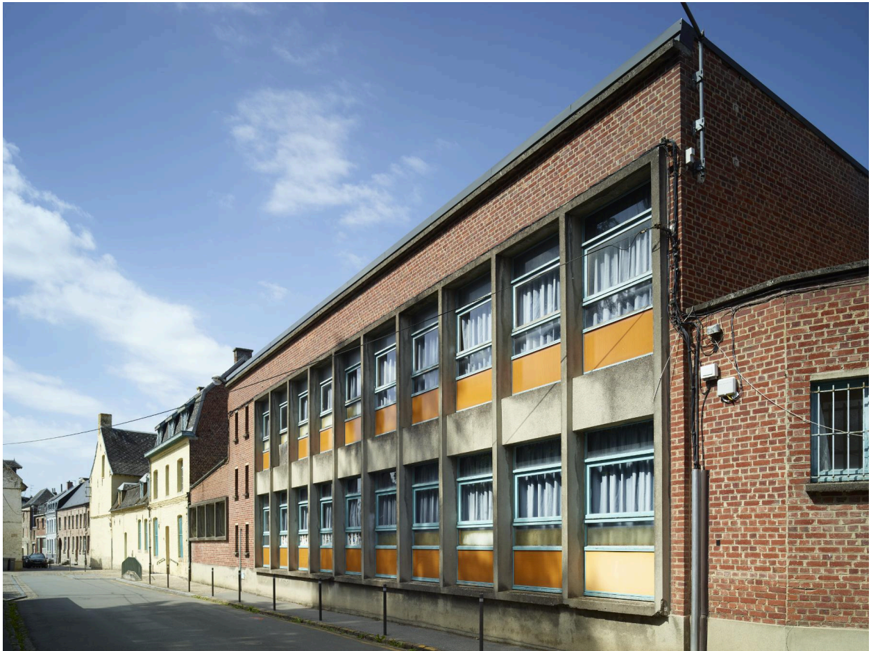
École de garçons : façade rue Chevray de l'aile construite dans les années 1960. Vue orientée ouest - est.
