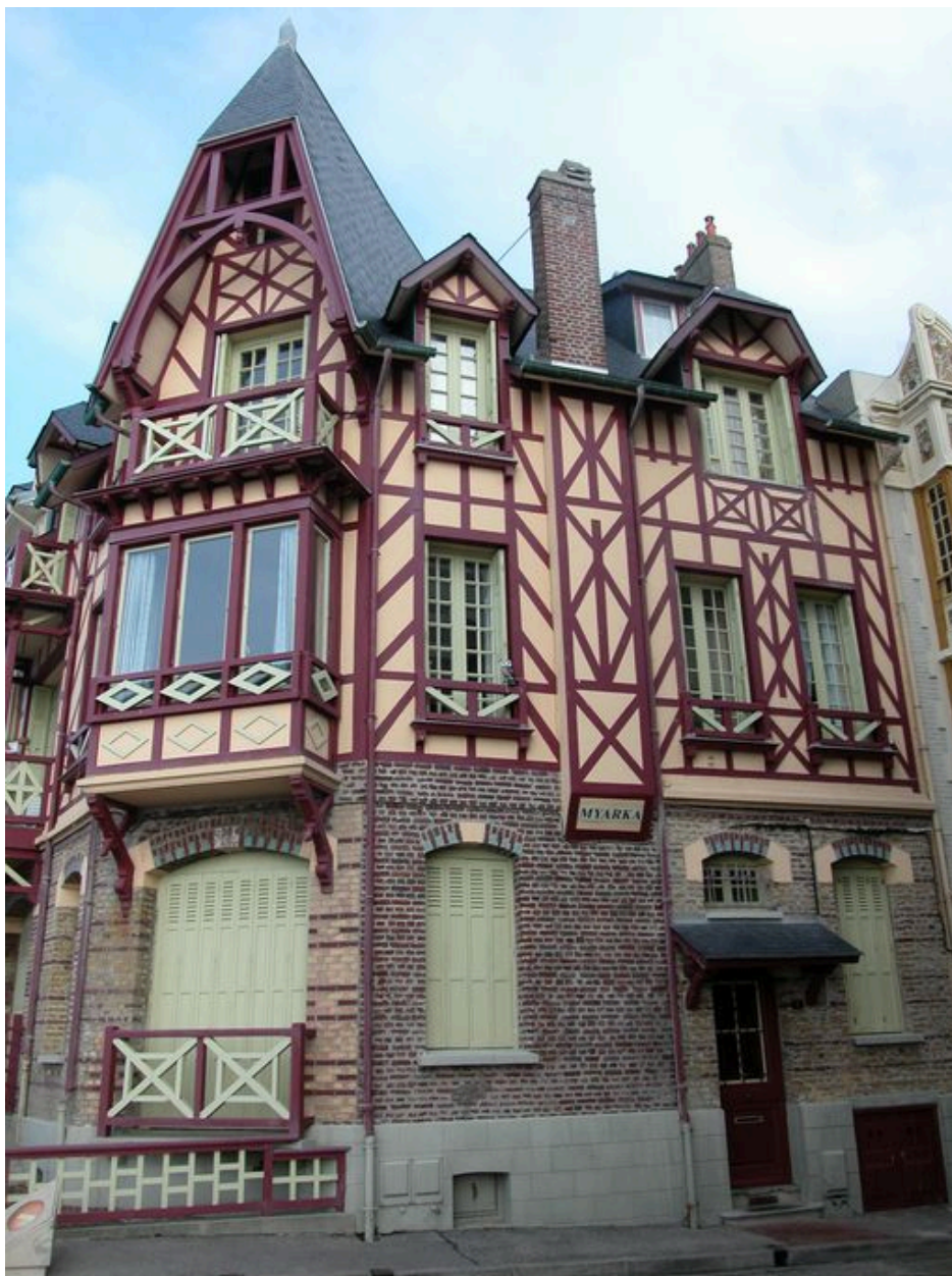
Façade sur la rue Faidherbe.
