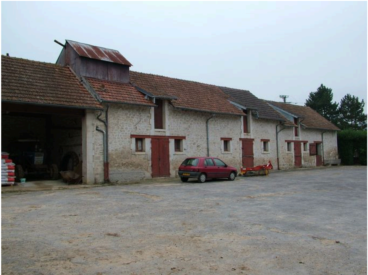
Vue des étables et écuries.
