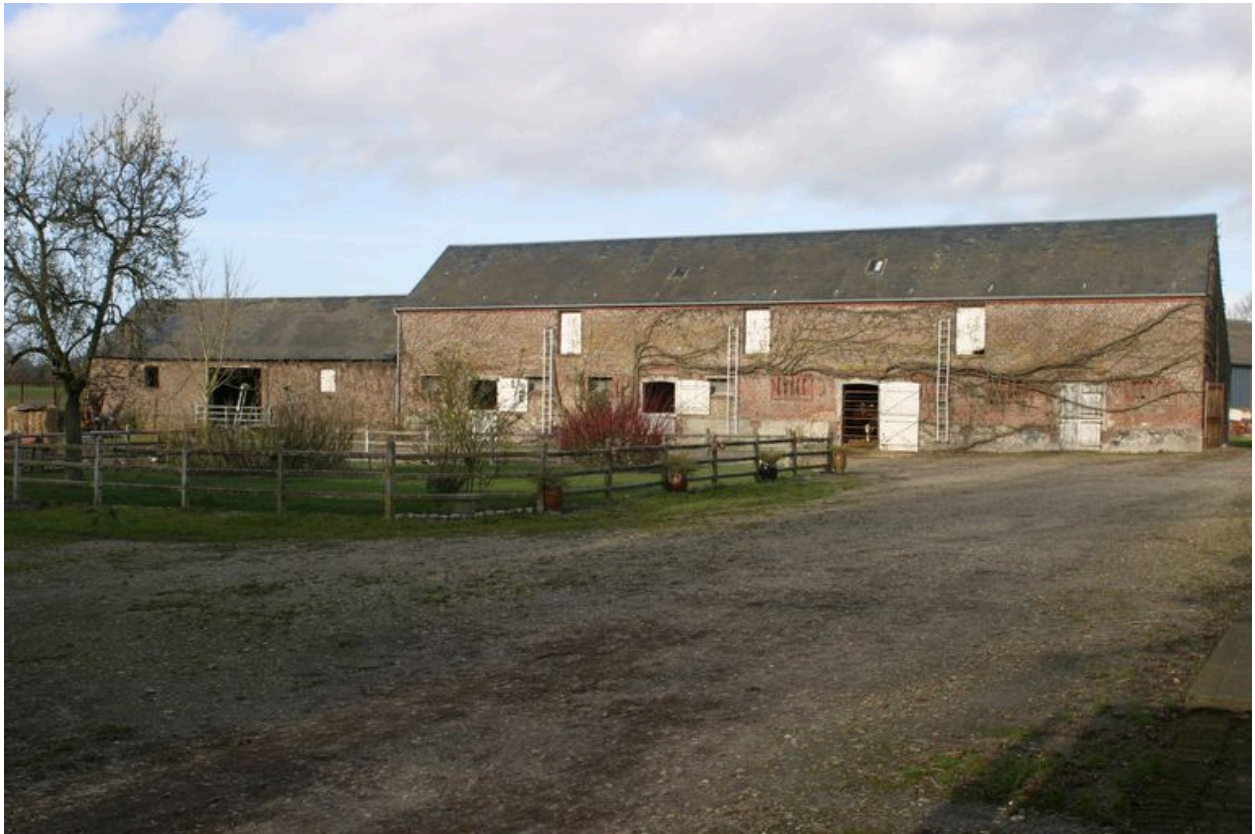
Vue des écuries depuis l'entrée de la propriété.
