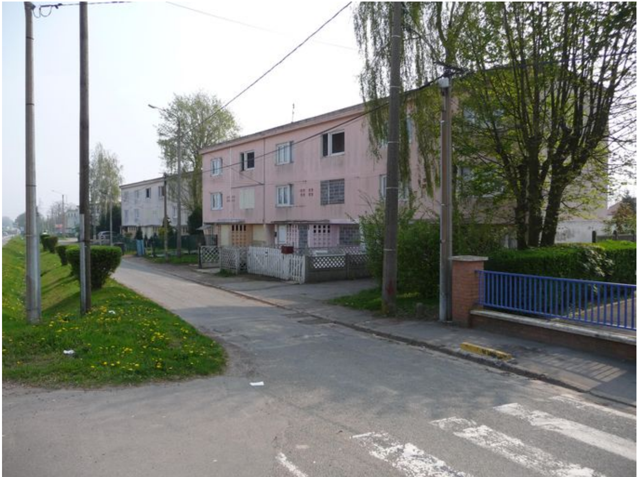
Vue générale d'un groupe de six logements.
