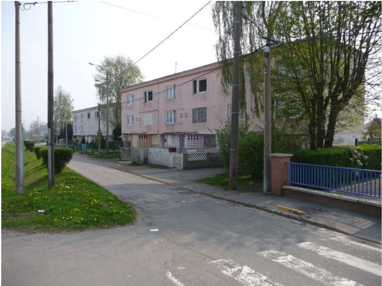
Vue générale d'un groupe de six logements.
