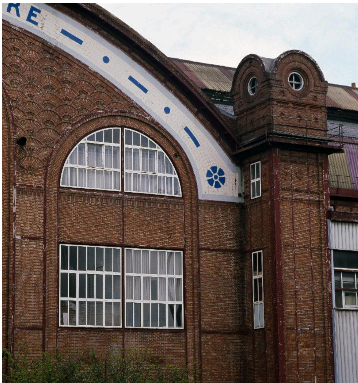
Détail de l'appareillage de brique de la façade du laboratoire.
