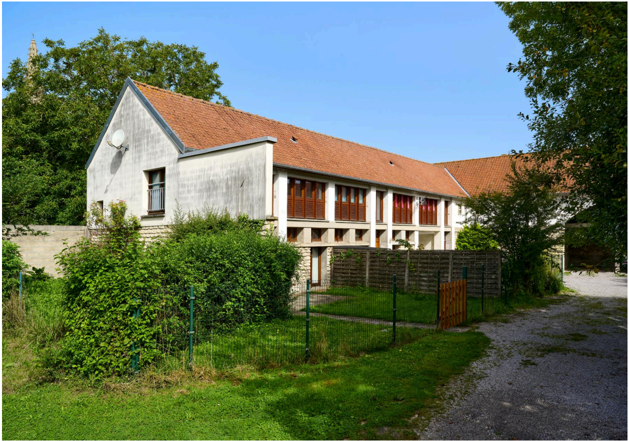
Vue sud des bâtiments agricoles, prise depuis la cour.
