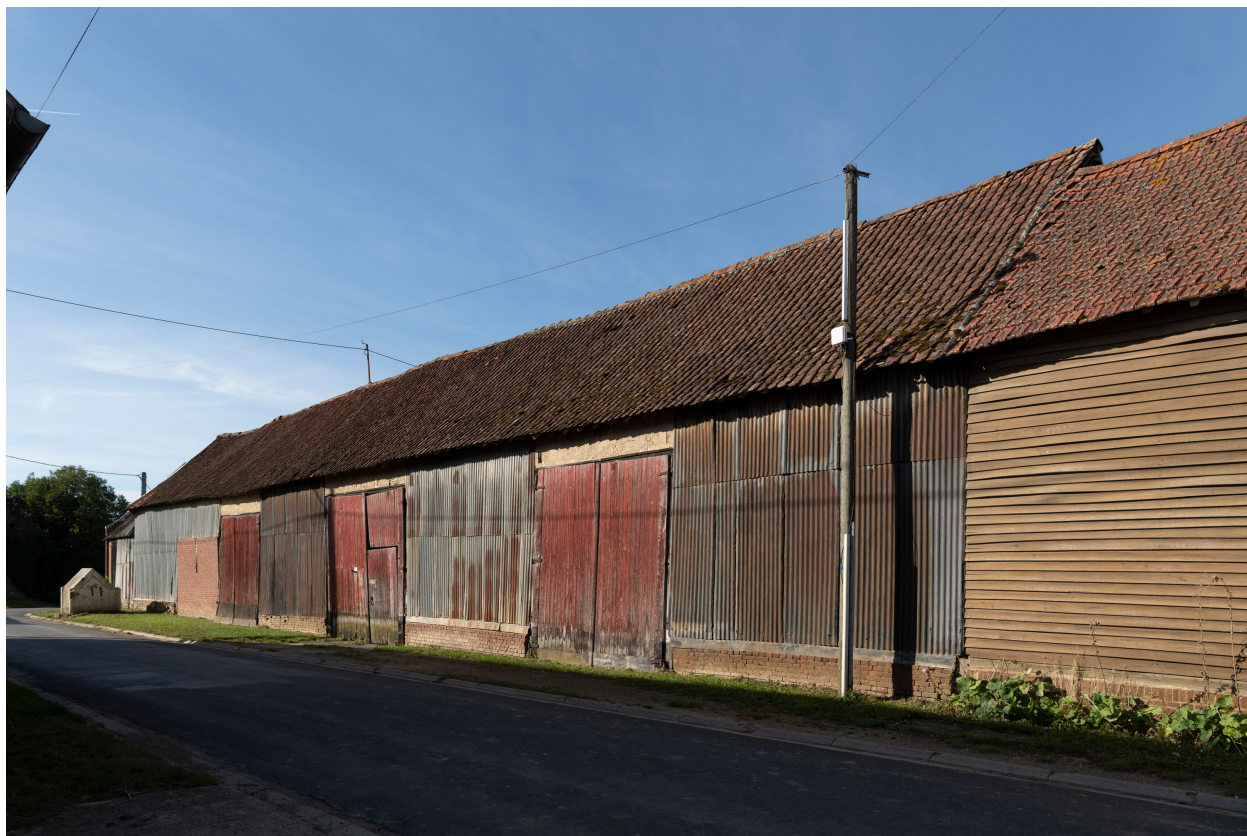
Alignement de granges de la rue de Plainville, vue prise depuis le nord-est.
