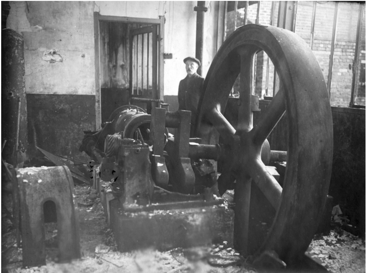
Salle des machines : machine à gaz pauvre Duplex détruite, 1919 (AD Aisne).
