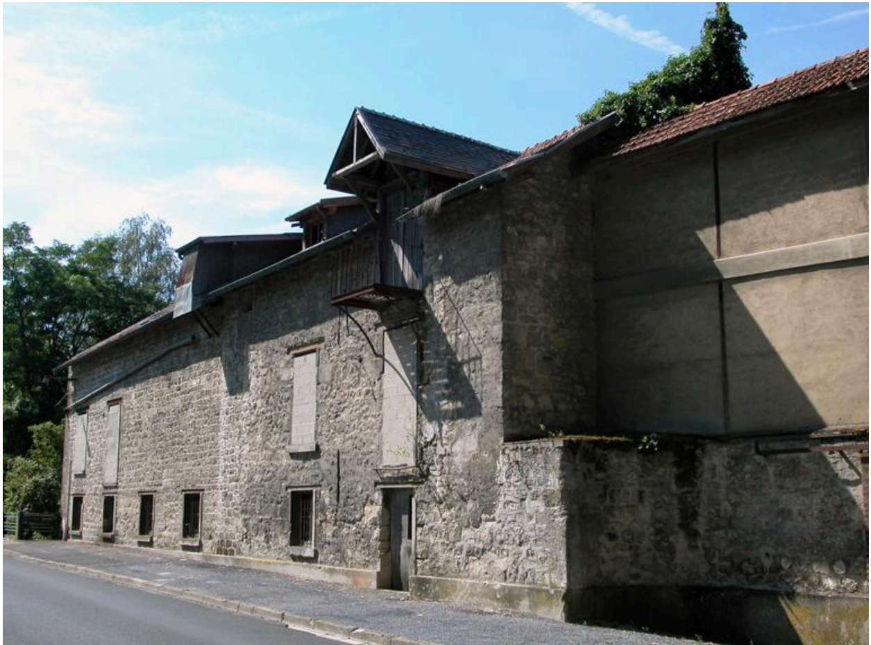
Vue des ateliers de fabrication.
