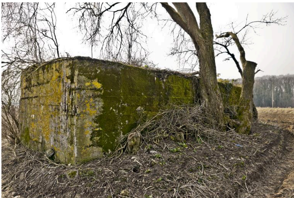
Vue de trois-quarts arrière, vers sud-ouest
