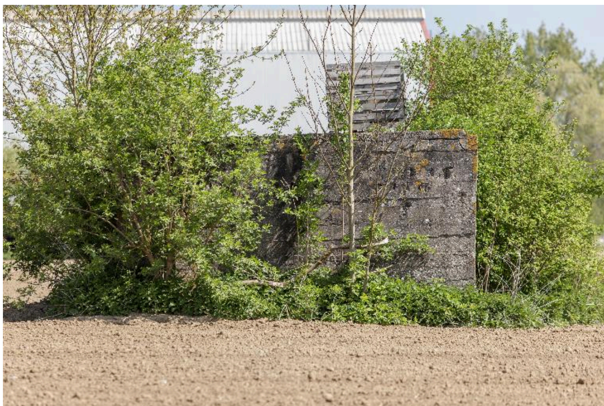
Vue latérale, vers le nord-est
