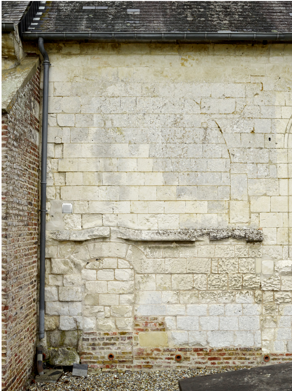
Détail de la maçonnerie de l'élévation sud du chœur, ancienne porte.
