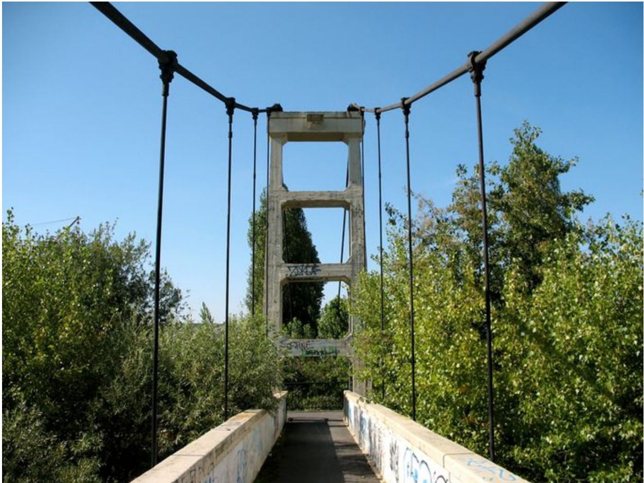
L'un des deux piliers (côté Villers-Saint-Paul) et ses haubans.
