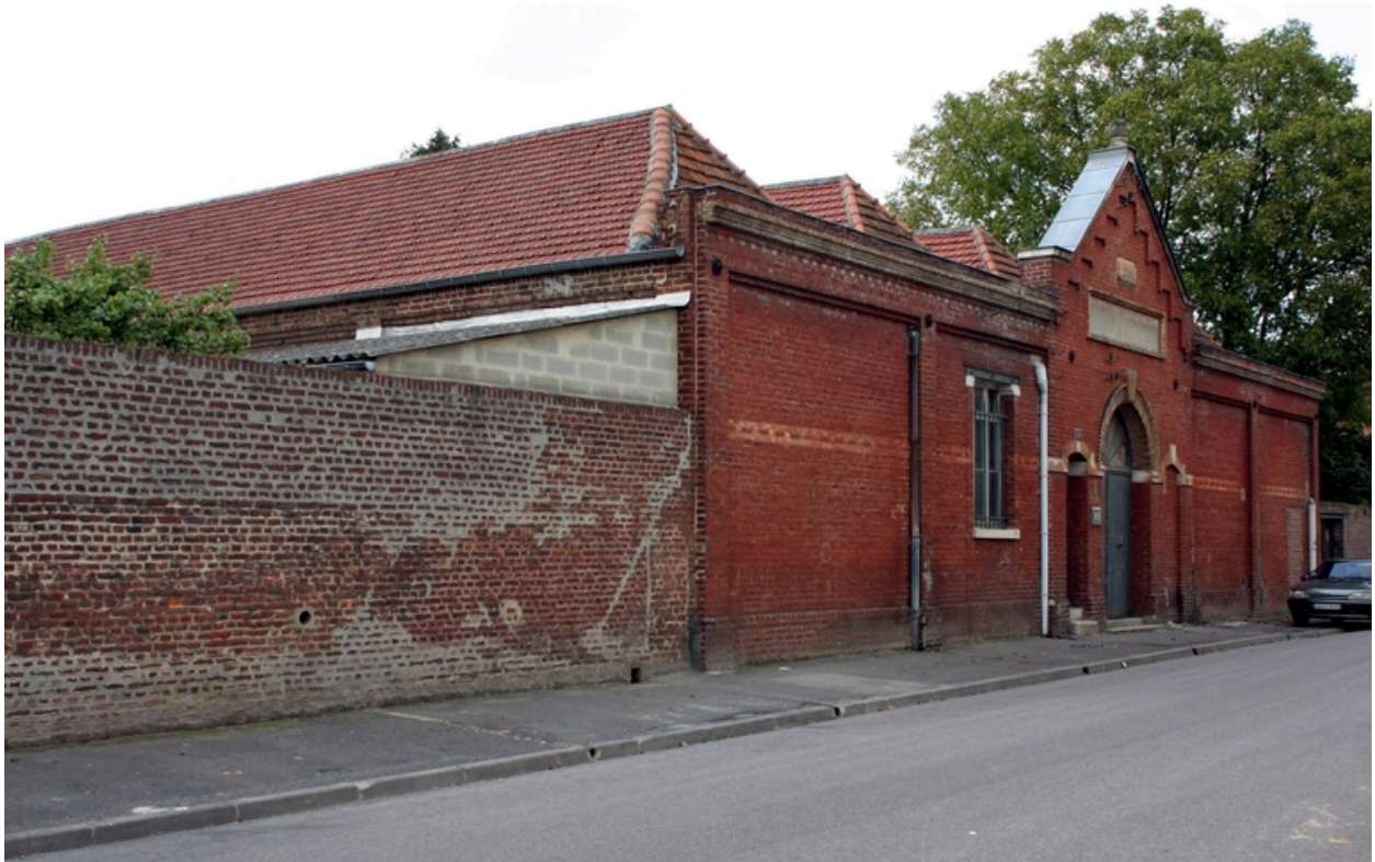
Les ateliers construits en 1907.
