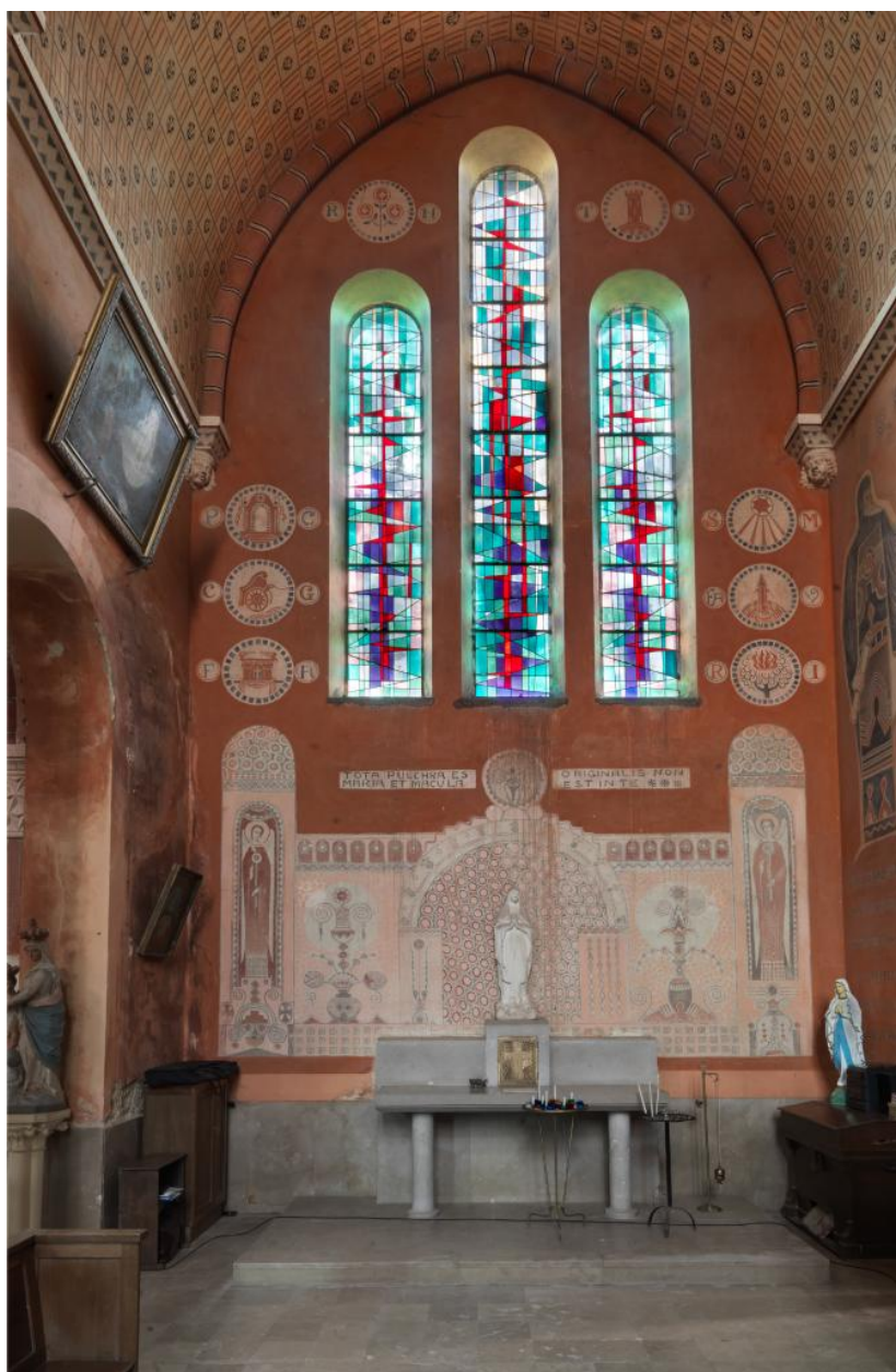
Vue intérieure du bras nord du transept.
