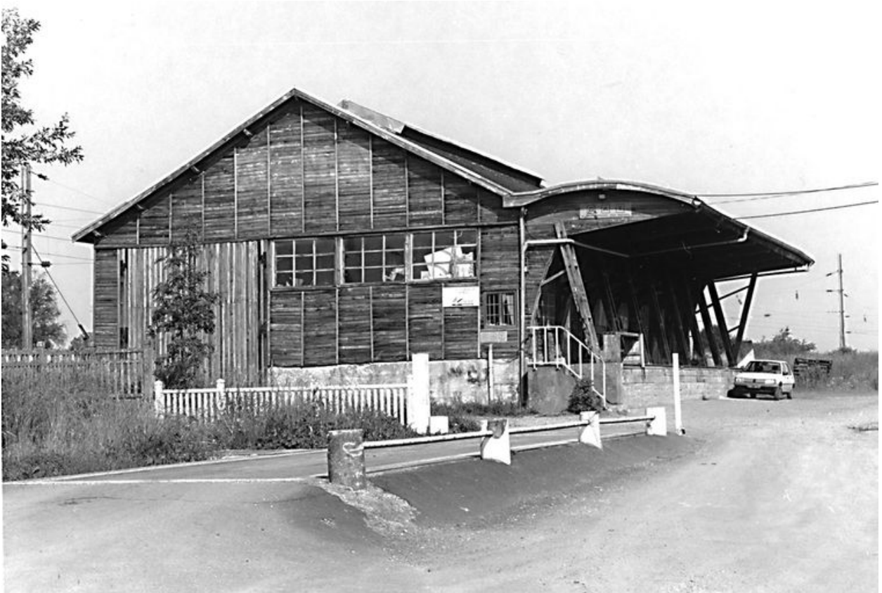
Entrepôt de marchandises.
