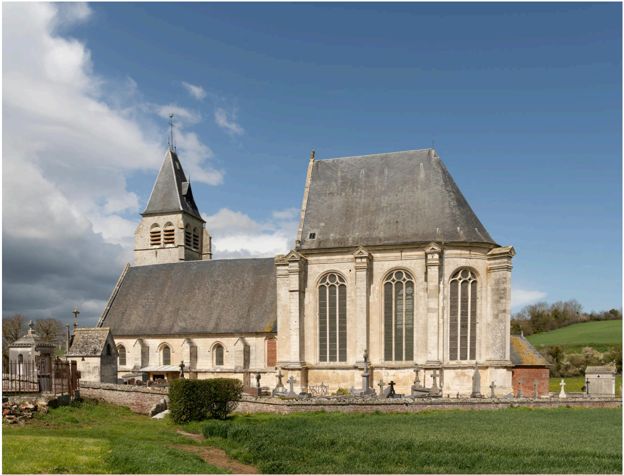
Vue générale, prise depuis le sud, de l'église entourée du cimetière.
