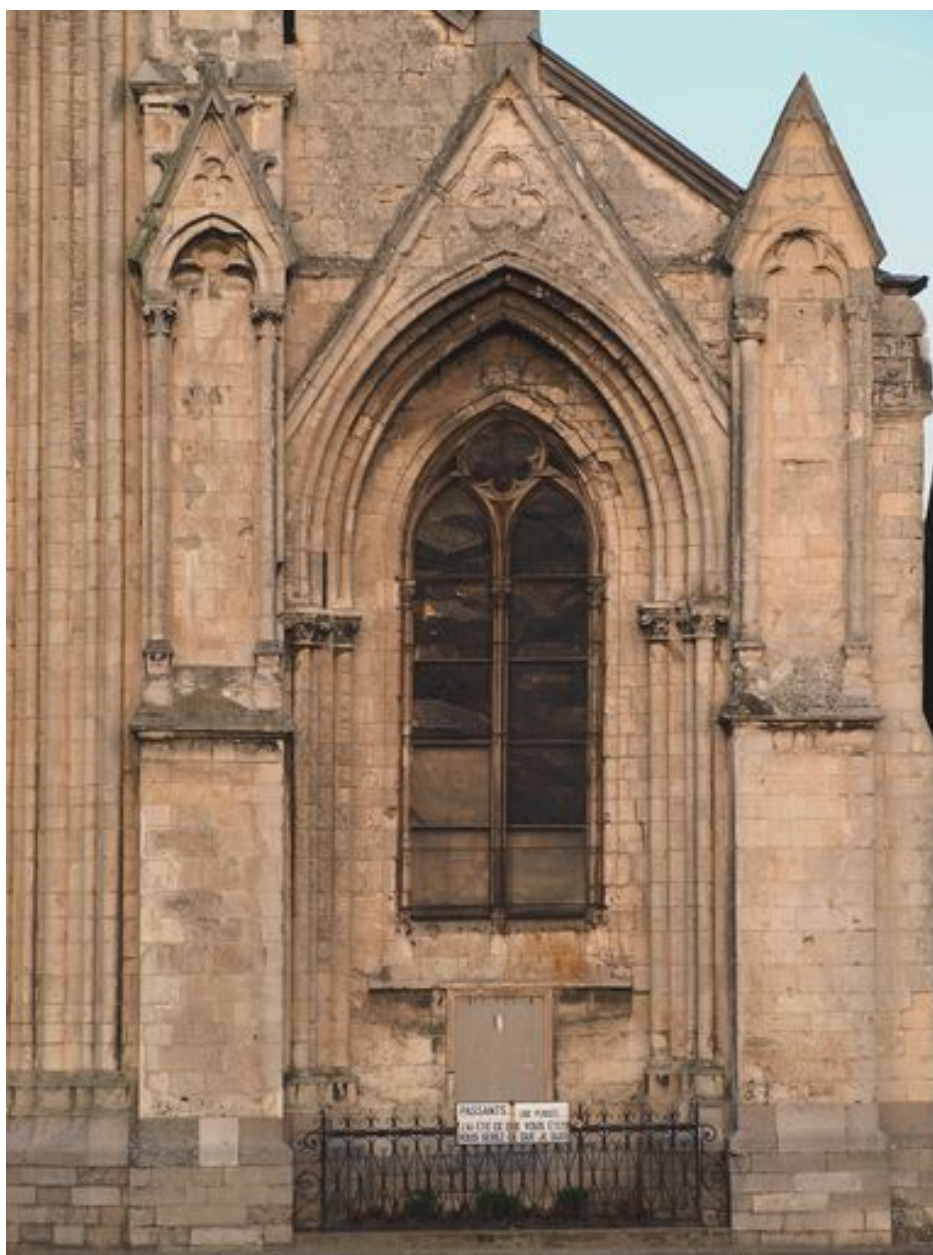
Baie occidentale du bas-côté sud
