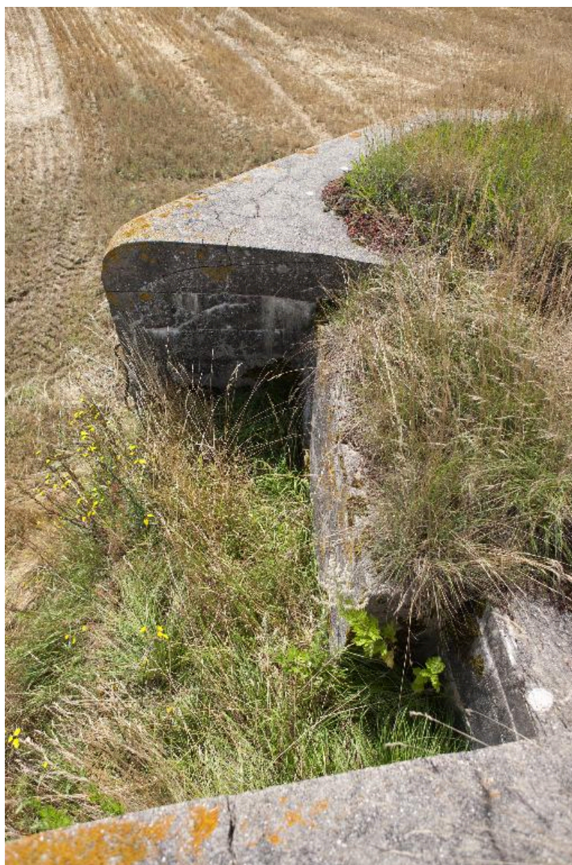
Banquette de tir depuis le couverture, vers le sud-est
