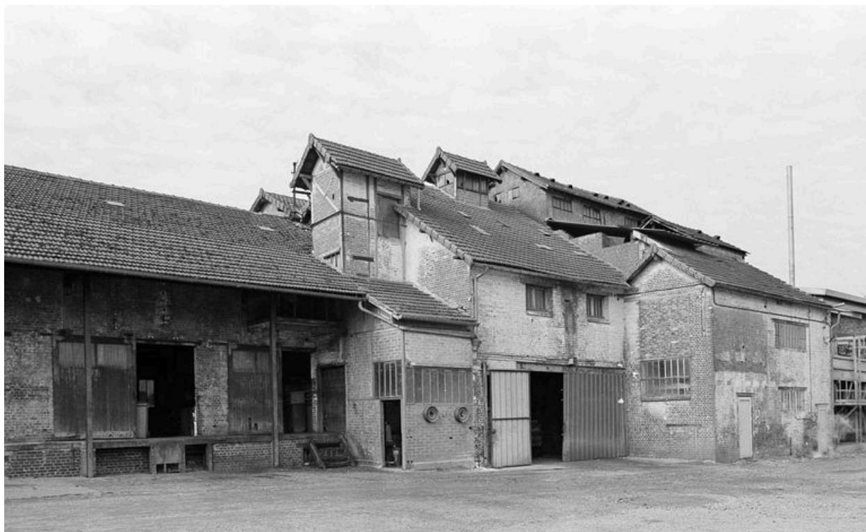
Atelier de fabrication : flanc est.
