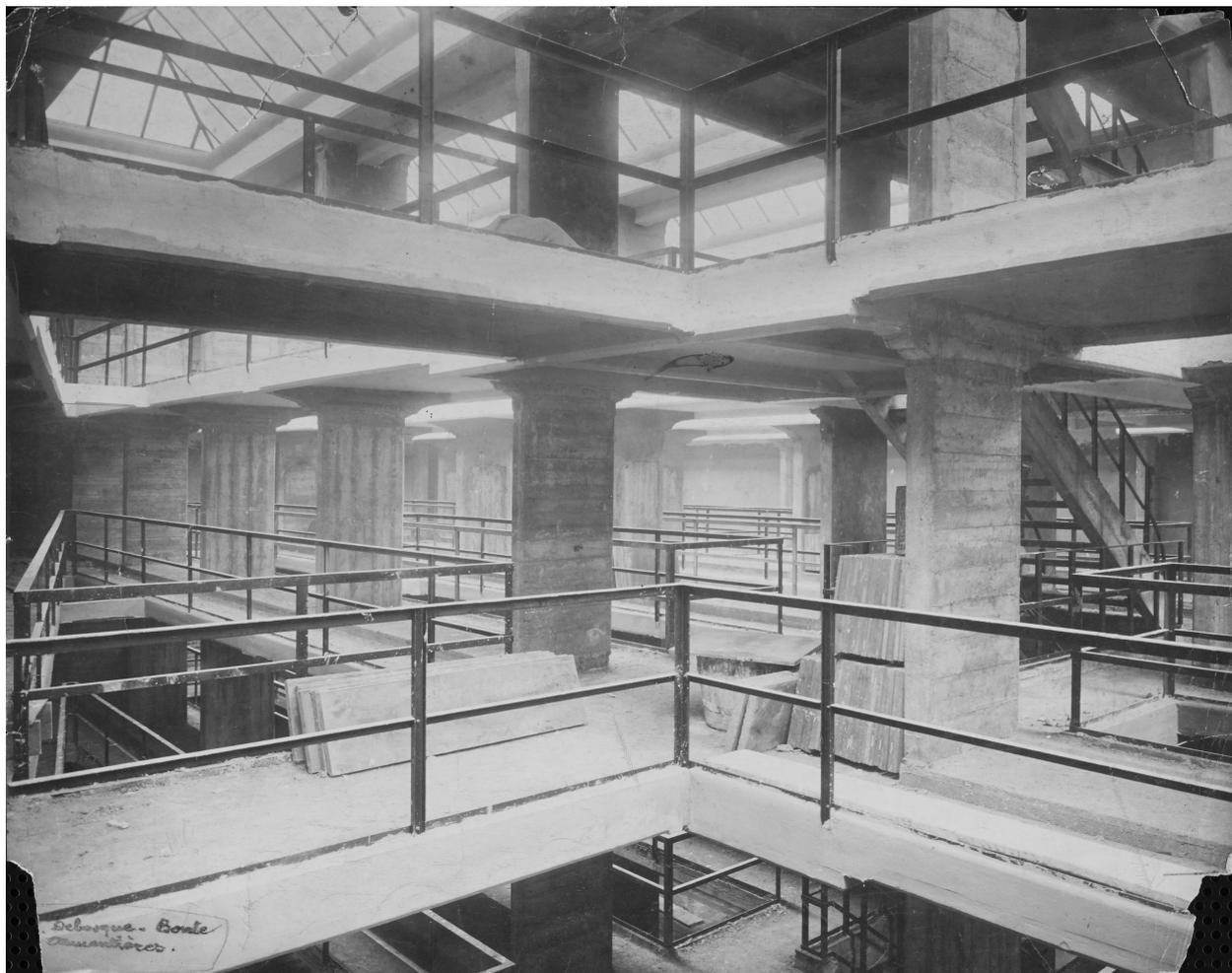
Intérieur du bâtiment du dépôt en chantier, vue prise depuis le vaisseau 4. Au sol, les rayonnages en béton attendent d'être montés sur les structures porteuses. Photographie (IFA ; 076 lfa 108/10 : 2-3-047).
