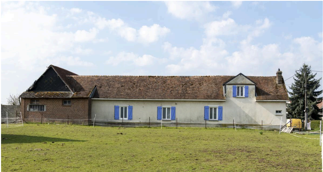
Logis d'une ancienne ferme, n°3 chemin Brunehaut, vue depuis le nord.
