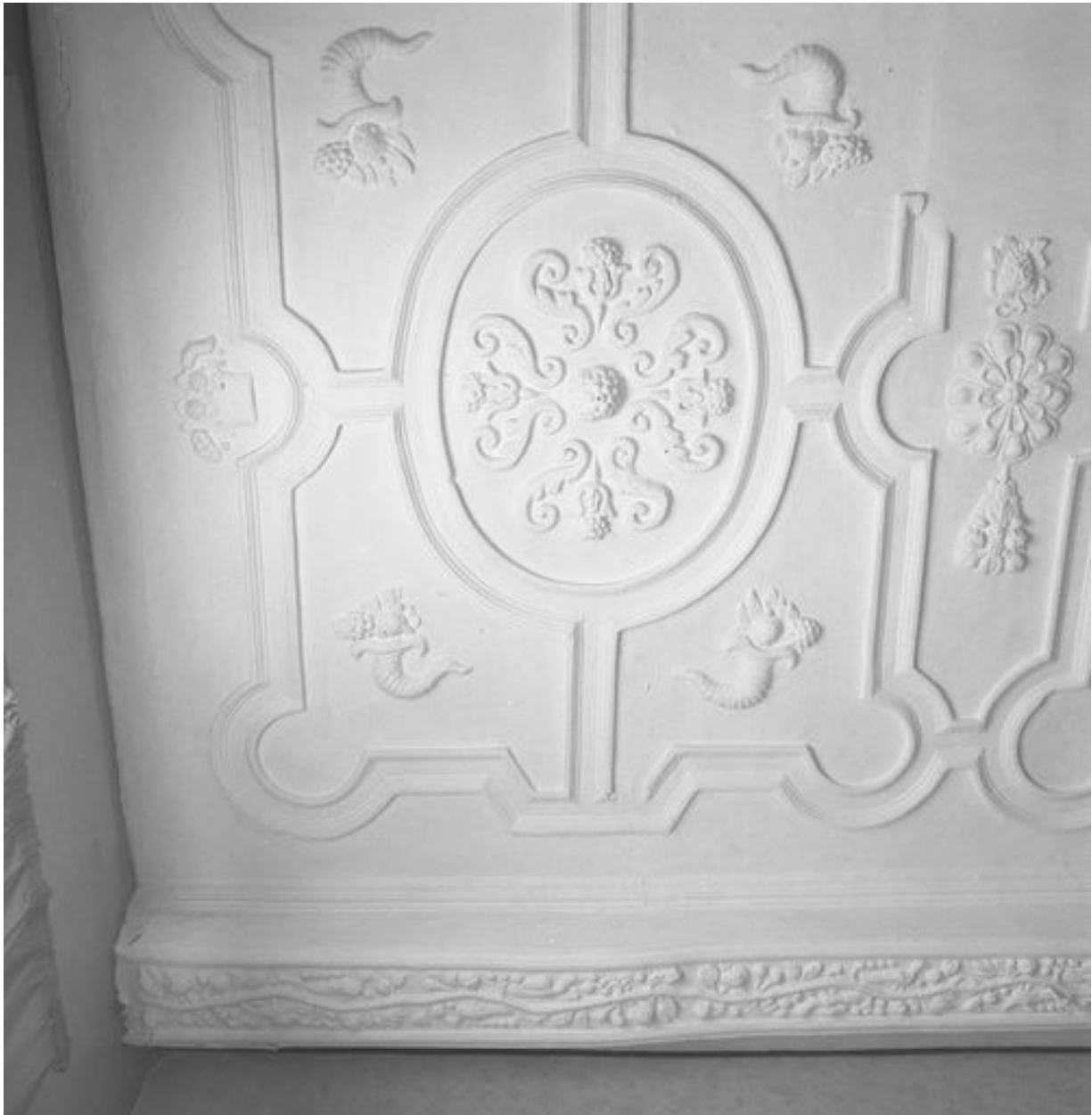
Vue partielle du plafond coupé par le cloisonnement en logements (ici, n° 37 rue de la Cavalerie).
