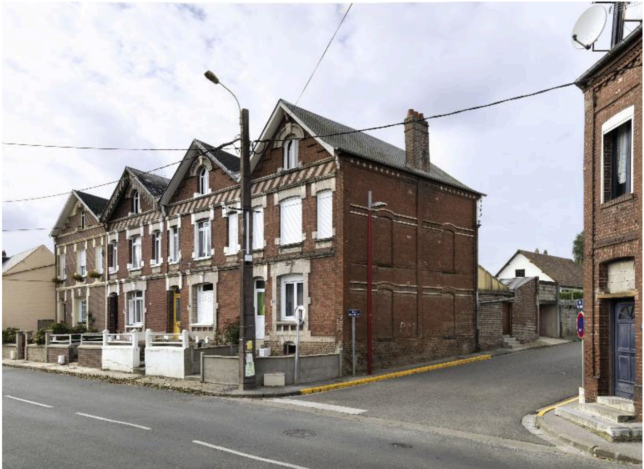
Vue de trois-quarts depuis la rue du Bas.
