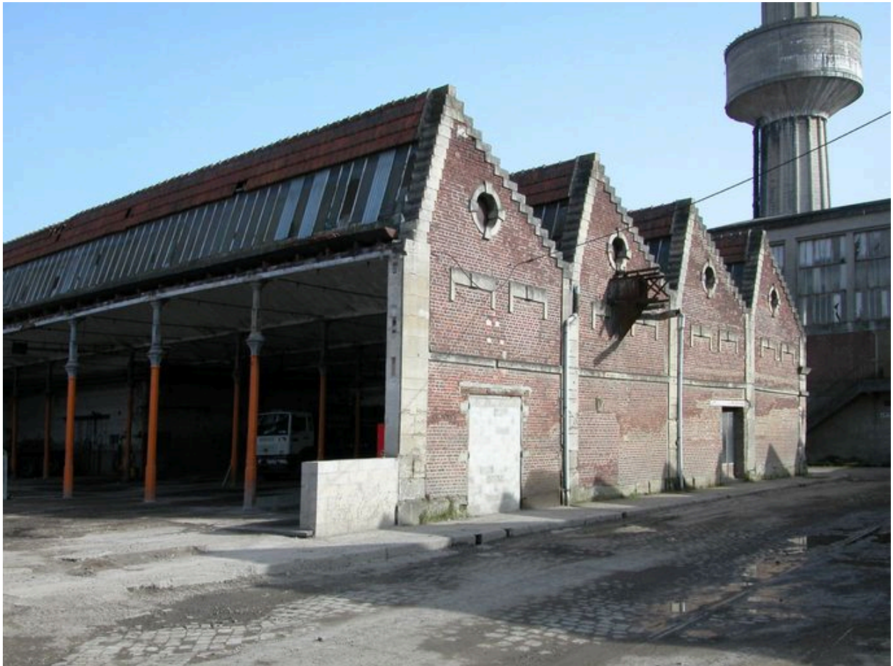
Vue des ateliers de fabrication.
