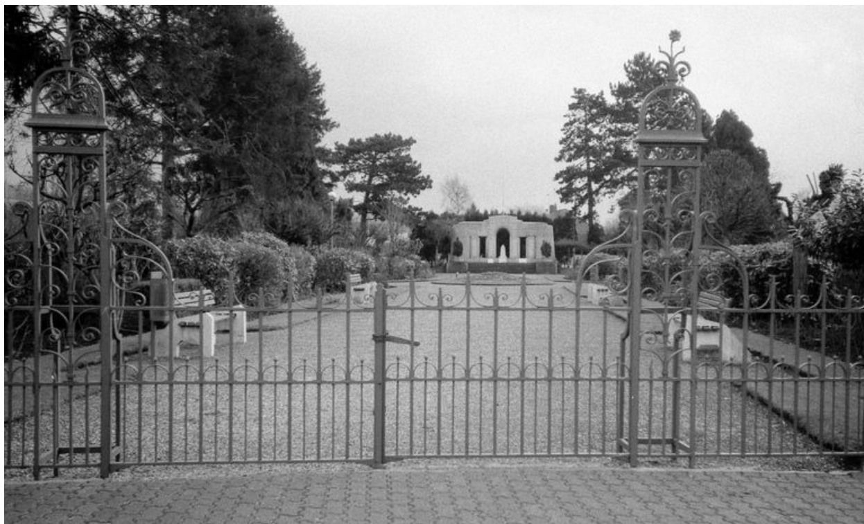
Vue générale, depuis la grille d'accès.
