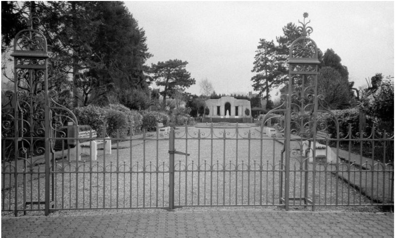
Vue générale, depuis la grille d'accès.
