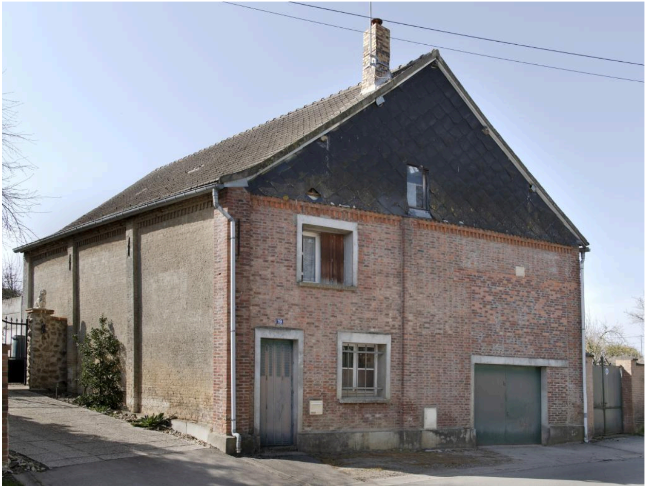
Ancienne grange aménagée en maison, construite en 1869, n°19 rue du Chauffour, vue depuis le sud-est.
