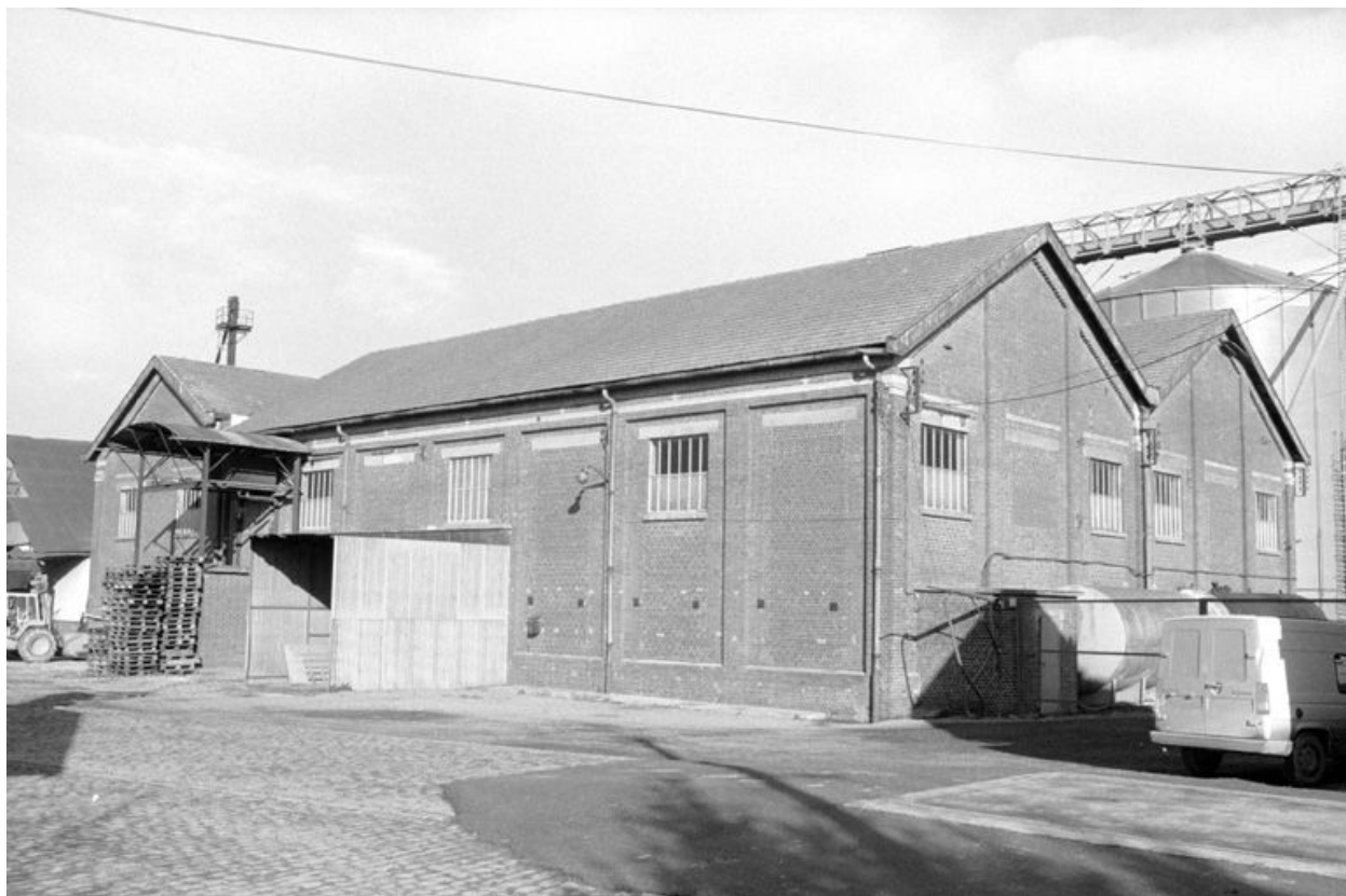
Atelier de fabrication, vue partielle.
