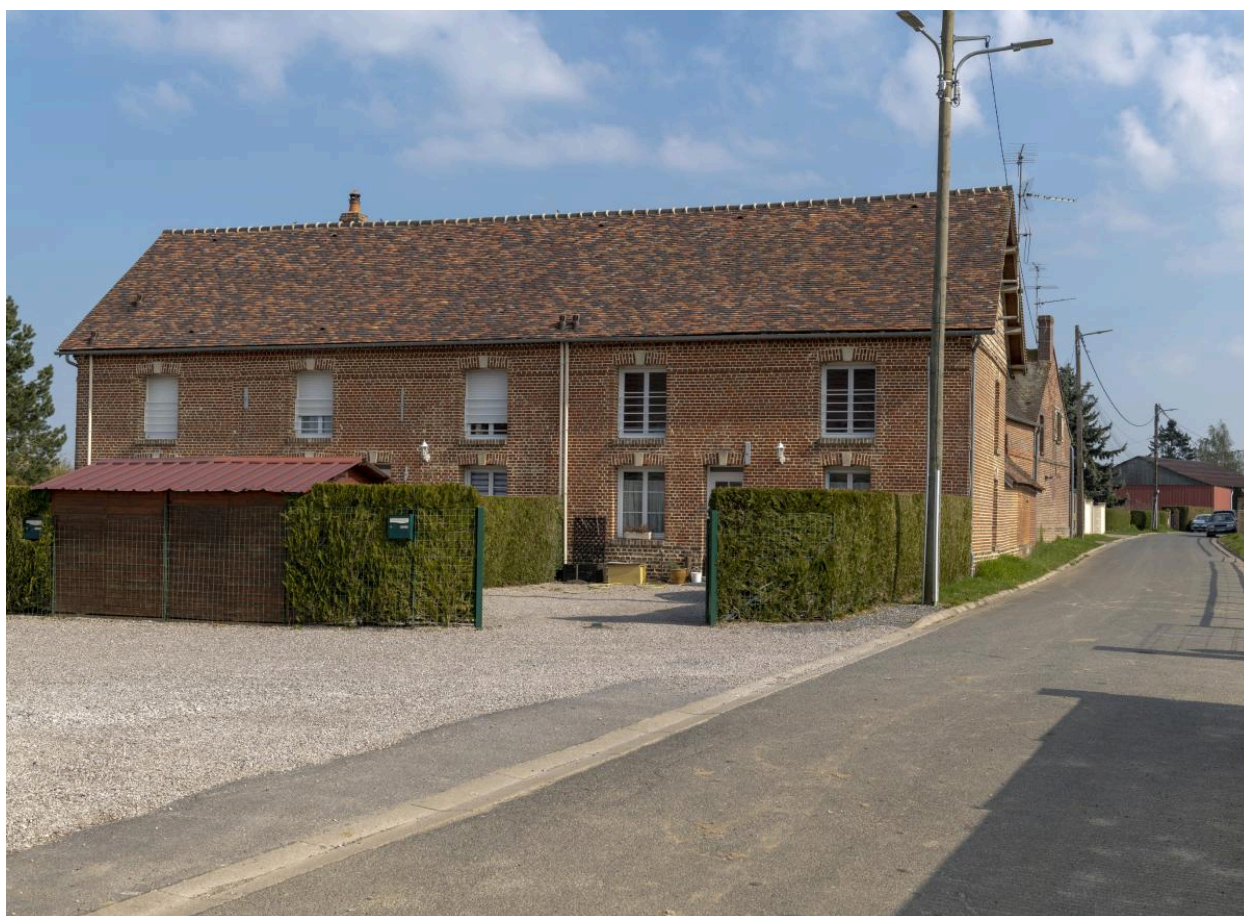
Logements, n°12B chemin Brunehaut, vue depuis le sud-est.
