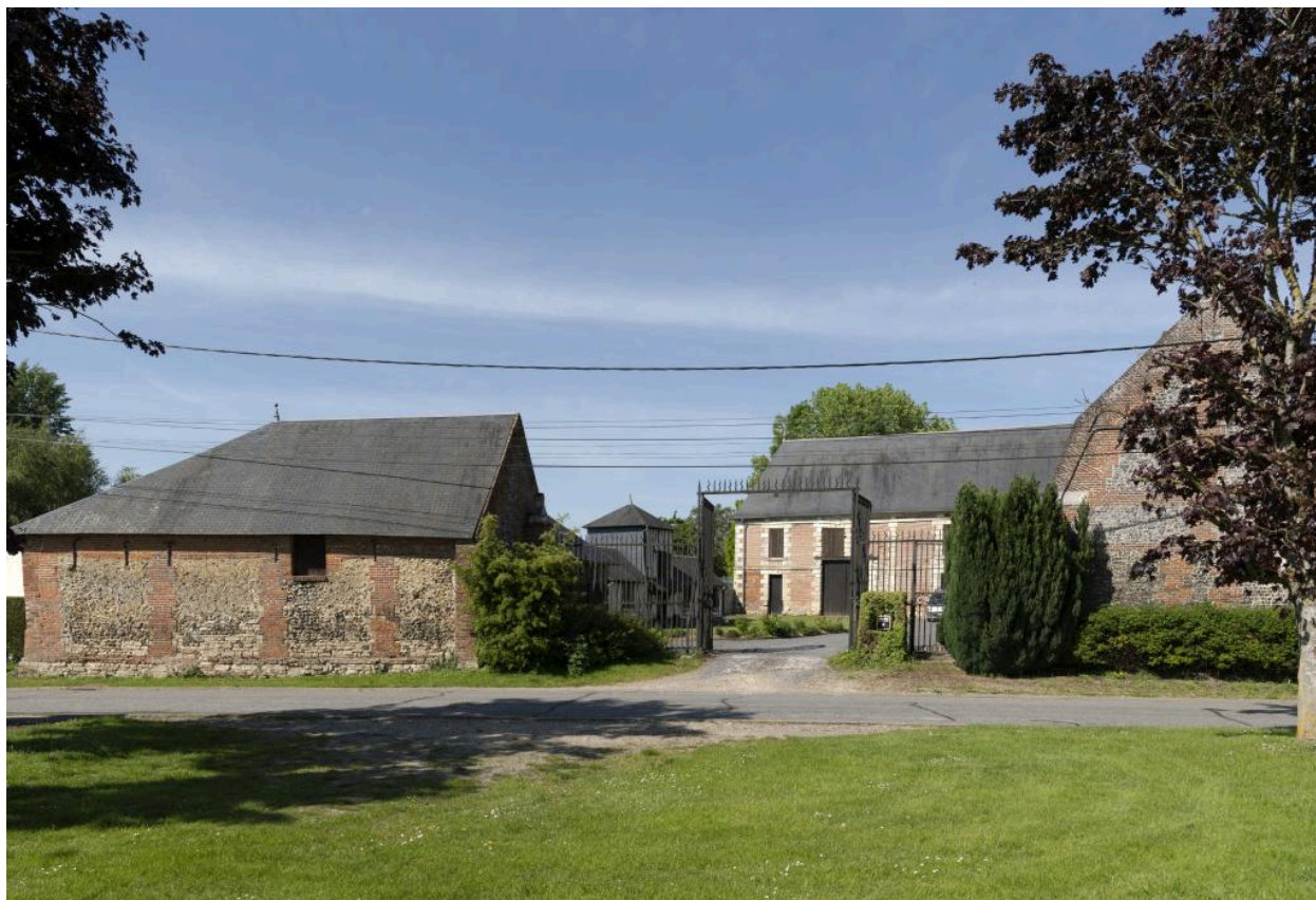
Vue générale de la ferme côté est depuis la place publique
