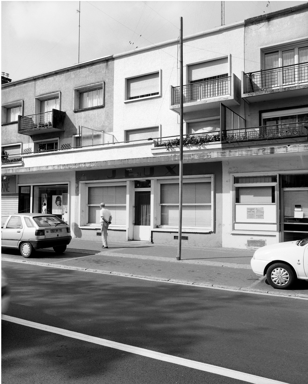
Vue générale d'un module avec magasin bien conservé au rez-de-chaussée, îlot M.
